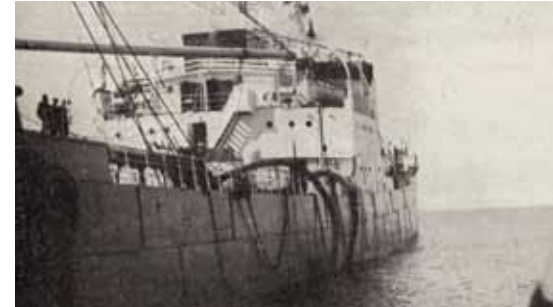
Le bateau-réservoir anglais British fusilier recevant par deux tuyaux dans le port d'Haïfa le pétrole amené de Mésopotamie par le pipeline
